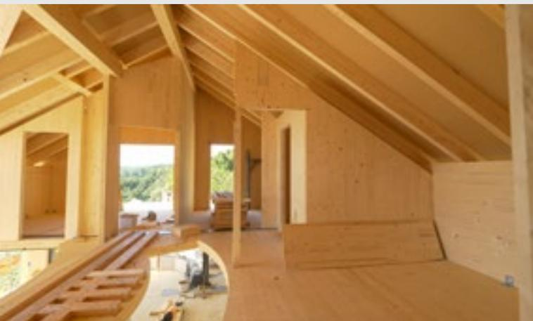
Die CLT-Bauweise (Brettsper Holz) ist eine innovative Methode, bei der strukturell verstärkte Holzplatten verwendet werden, um nachhaltige und moderne Gebäude zu schaffen.
